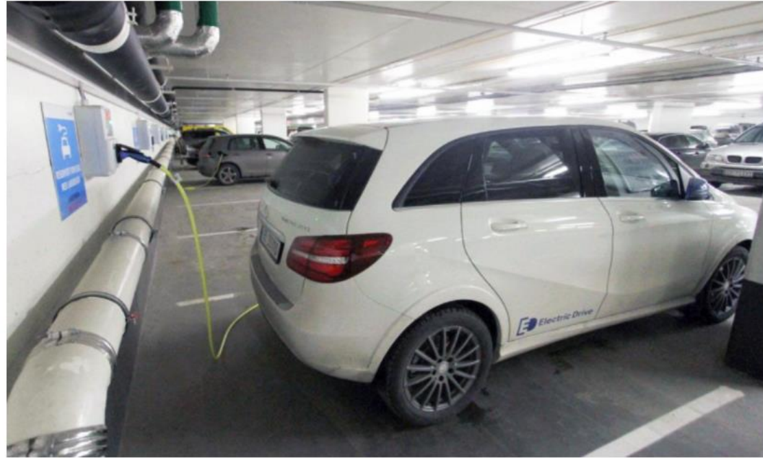
FELLESGARASJE: Ladestasjonen må du trolig betale selv, men styret i et sameie plikter å legge til rette for lading av elbil. Borettslag vil trolig følge etter ganske snart. Foto: Norsk Elbilforening
