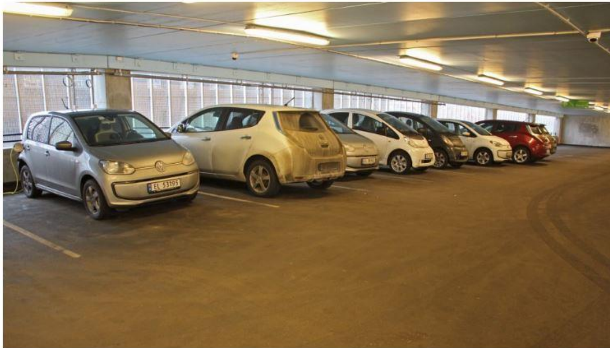
Stadig flere elbiler står til lading inne i parkeringshus og garasjeanlegg.
